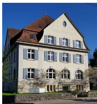
Spitex Zentrum Binningen
