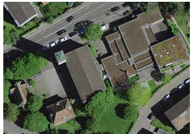
Das Calvinhaus (rechts) soll durch einen Neubau ersetzt werden.
